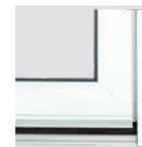
Vue extérieure. Rejet d'eau gris anodisé
