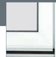
Vue extérieure. Rejet d'eau gris anodisé
